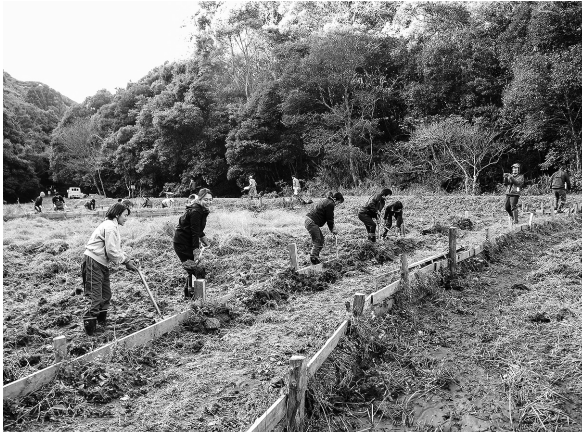
図14. 整備中の様子
